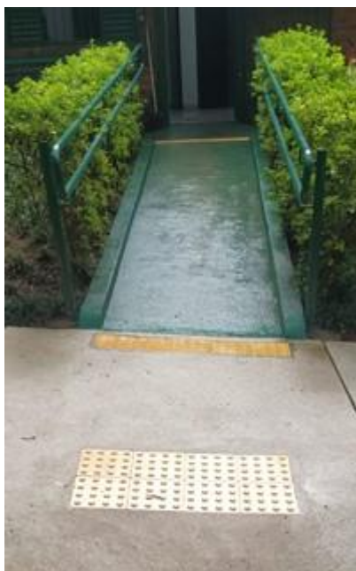
Figura 30: Rampa depois da reforma
