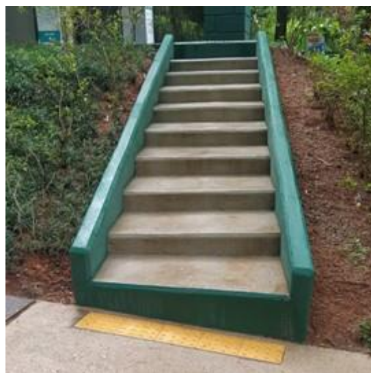
Figura 35: Escada depois da pintura
