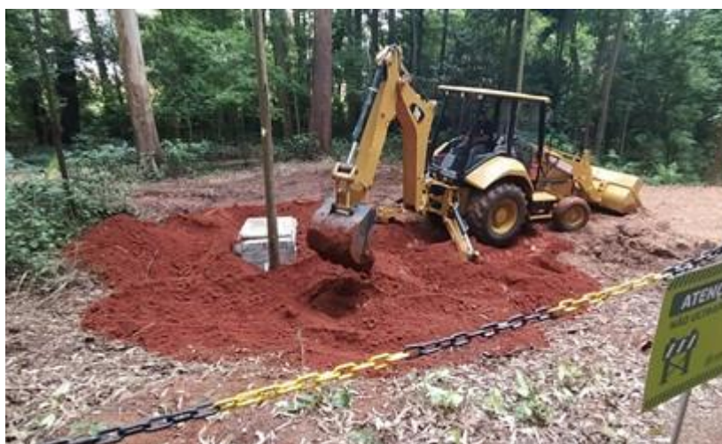
Figura 15: Preenchimento de terra e nivelamento do terreno
