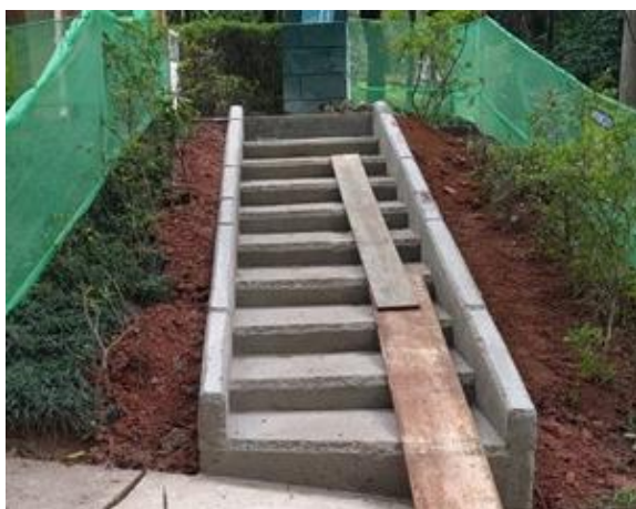
Figura 34: Escada durante a reforma
