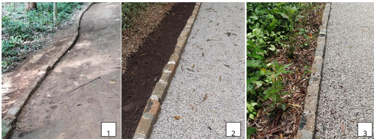
Figura 10: Etapas de reconstituição de canteiro. 1) Paralelepípedos e vegetação degradados. 2) Paralelepípedos reconstituídos e terra preta renovada. 3) Plantio no local e folhas pra proteger o solo do ressecamento.
